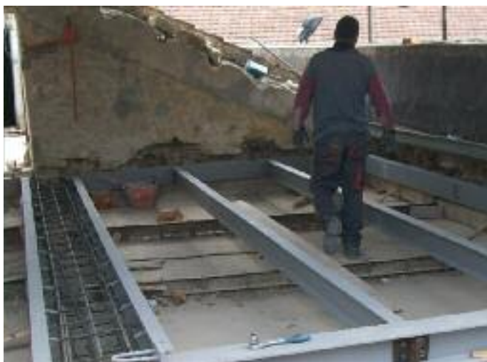
Nelle foto, alcuni interventi di consolidamento che hanno interessato l'ala destra dell'edificio scolastico.
